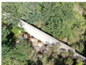
3. COSTRUZIONI IN CALCESTRUZZO ABBANDONATE
