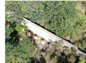
3. COSTRUZIONI IN CALCESTRUZZO ABBANDONATE
